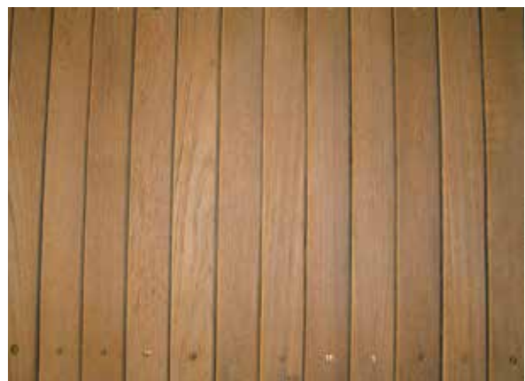
Panelen efter slipning där den ursprungliga vinkeln mellan not och fjäder återskapades.
