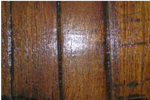
Panelen hade många skador och vinkeln mellan not och fjäder var nästan igenmålad. Bilden visar en närbild på panelen på den ena gaveln som sparades som referensyta.
