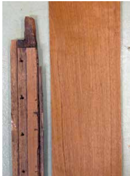
Ett bottenstycke från en fönsterbåge som visar hur nedslipad ytan var, glasstiften syns i ytan. Bredvid ligger teak-faner som användes för att bygga upp ytan igen.
