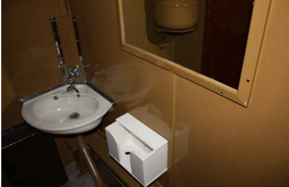
Toaletterna rengjordes och bättringsmålades på väggar och tak.
