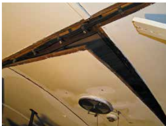
Taket innan restaureringen.
