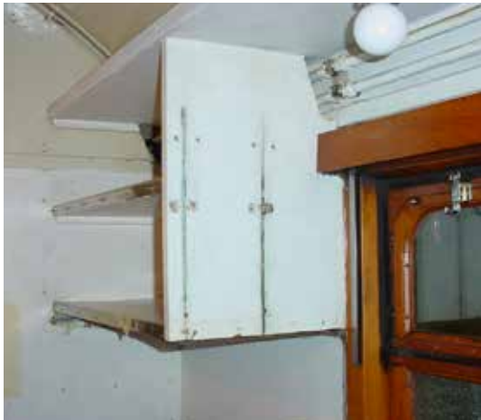
Hörnet av köket mot kallskänken innan åtgärder, fotograferat 2004.
