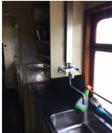
Hörnet av köket mot kallskänken efter åtgärder, fotograferat år 2017.
