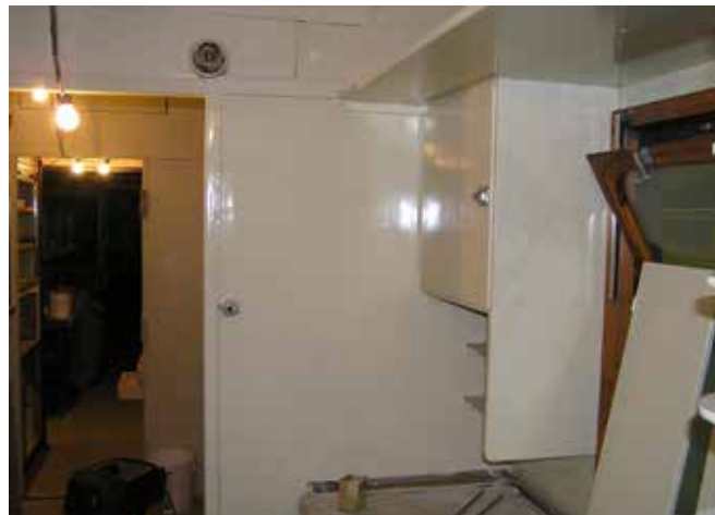
Hörnet av kallskänken mot penteriet efter åtgärder, fotograferat 2005.
