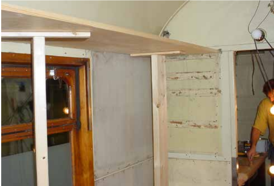
Arbete pågår med inredningen i köksdelarna. Längst till höger Thom Olofsson, fotograferat 2005.
