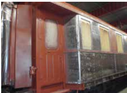
Taket är sprutmålat och rostskyddsbehandlingen av korgen är påbörjad.
