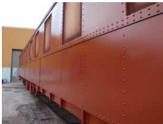
Närbild av rostskyddsbehandlingen av korgen.
