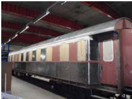
Intäckning har gjorts inför att taket ska målas.
