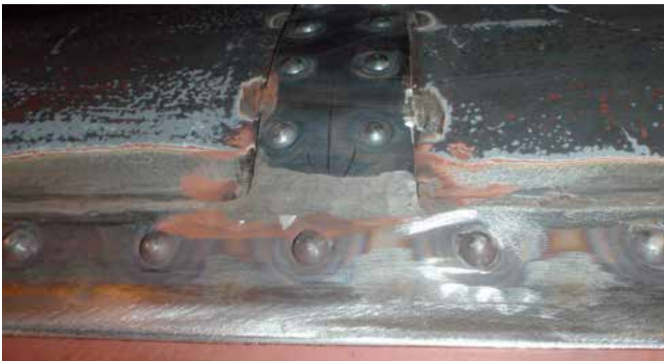
Närbild av det nya nitförbandet på taket.
