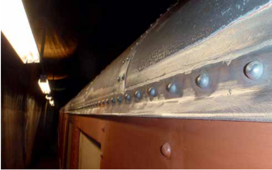
Det nitade ståltaket innan målning.
