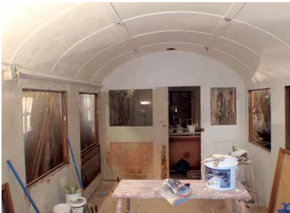
Målning av väggar och tak i vagnen.
