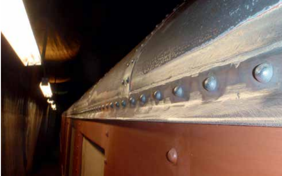
Det nitade ståltaket innan målning.
