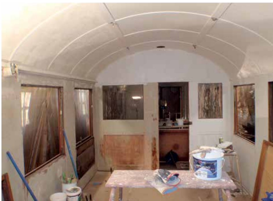
Målning av väggar och tak i vagnen.
