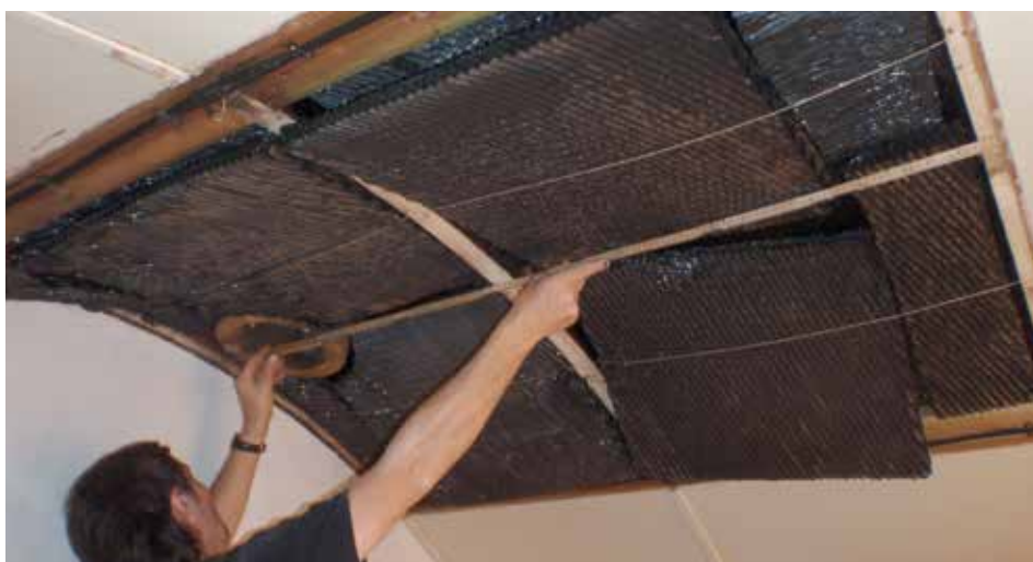
Björn Lindh mäter innertaket för att byta ut skadade masonitskivor.
