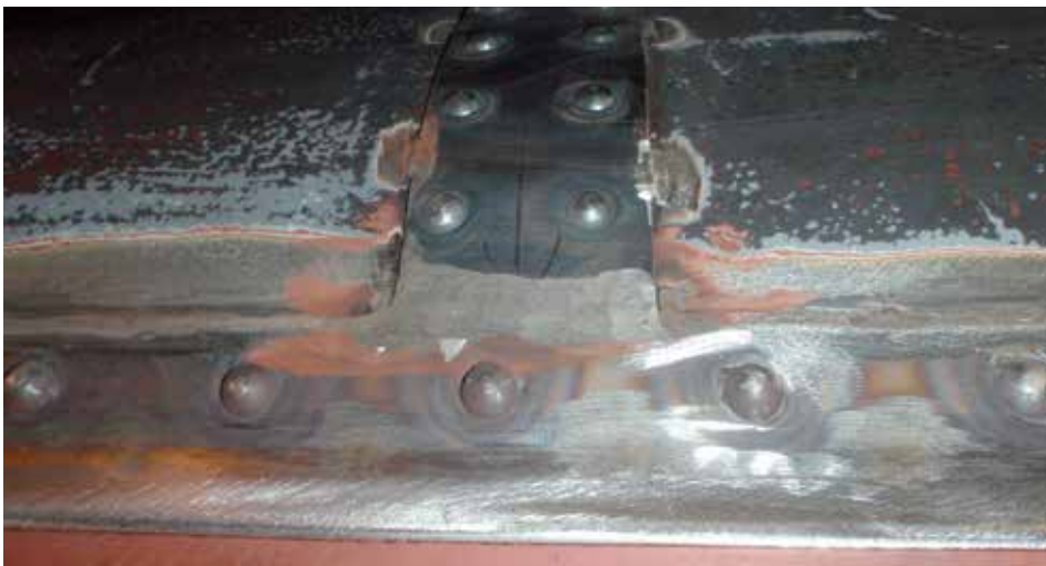
Närbild av det nya nitförbandet på taket.
